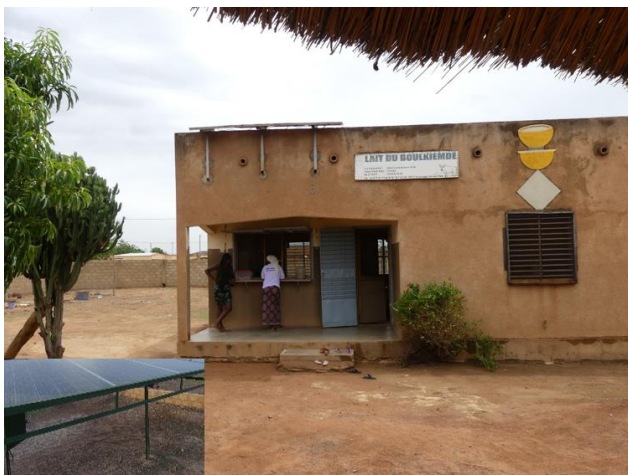
Panneaux photovoltaïques mini-laiterie KOUDOUGOU
