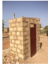
Latrine double-fosse NANGUIEPOU
